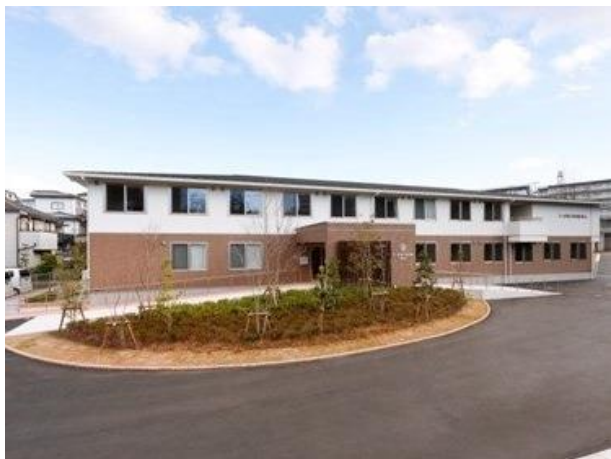
社会福祉法人こーぶ福祉会 ショートステイサービス併設 サービス付き高齢者向け住宅 「こ～ぶなごみの杜 桜ヶ丘」 外観
